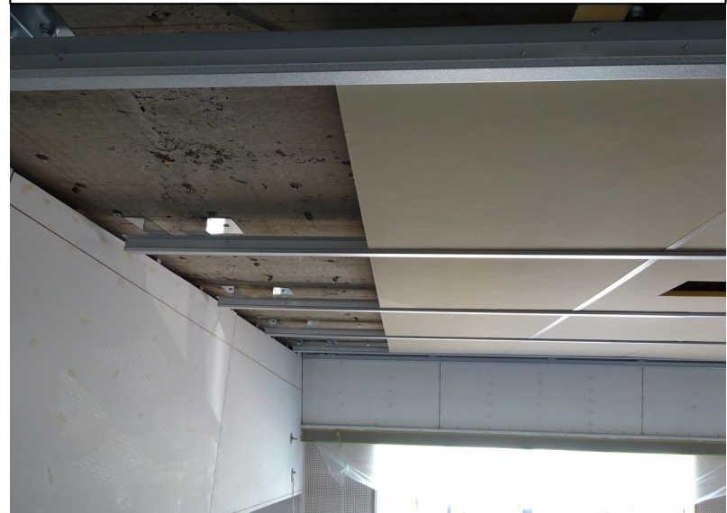
天井取り付け
