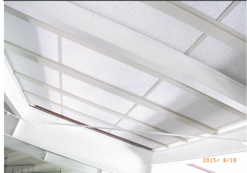
天井仕上げ②
