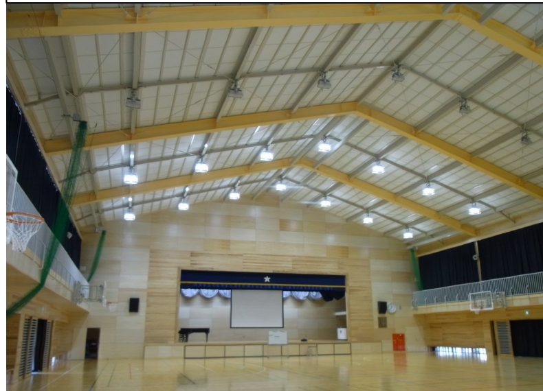
施工後全景②
