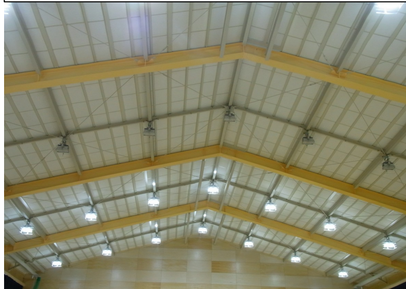
施工後全景③
