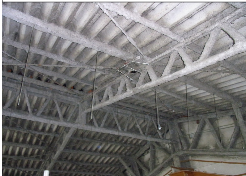
既存鉄骨状況(施工前)
