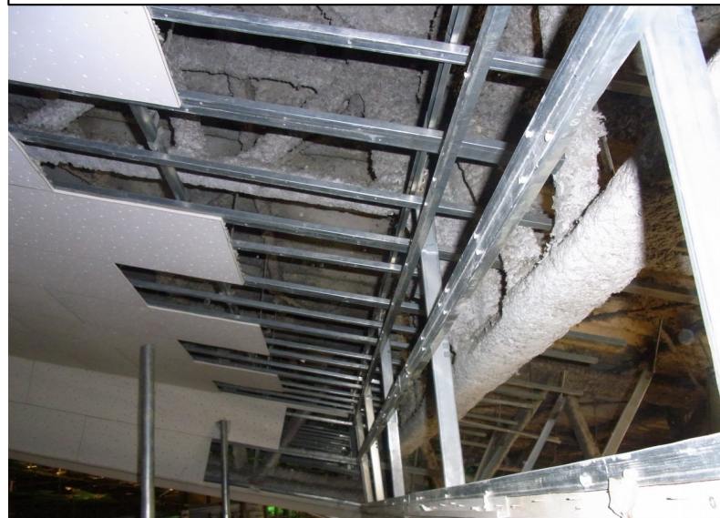
既存天井状況(撤去前)
