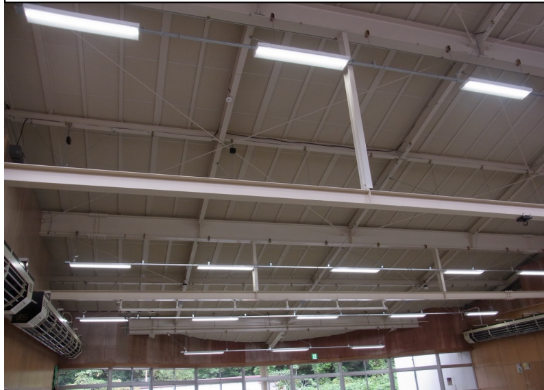
機能訓練室 仕上げ(全景)
