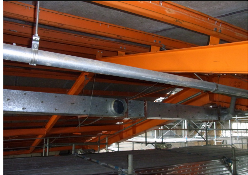
食堂 既存吊天井解体状況
