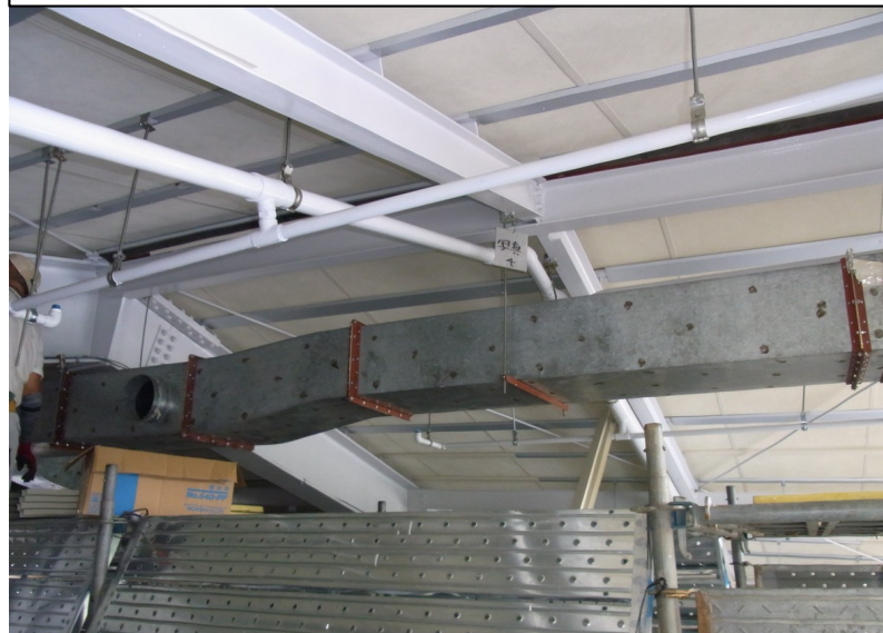
天井仕上げ材 取付
