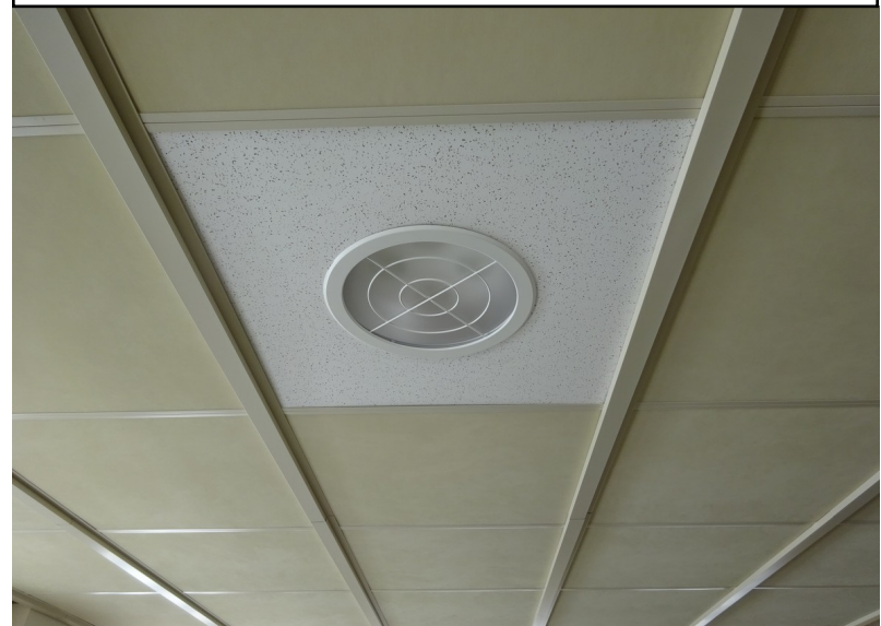
照明周辺部納め
