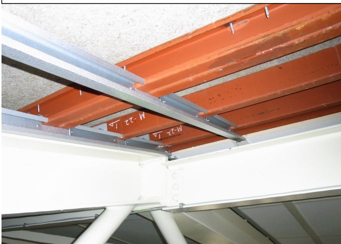
オープンスペース/ストッパー取付け
