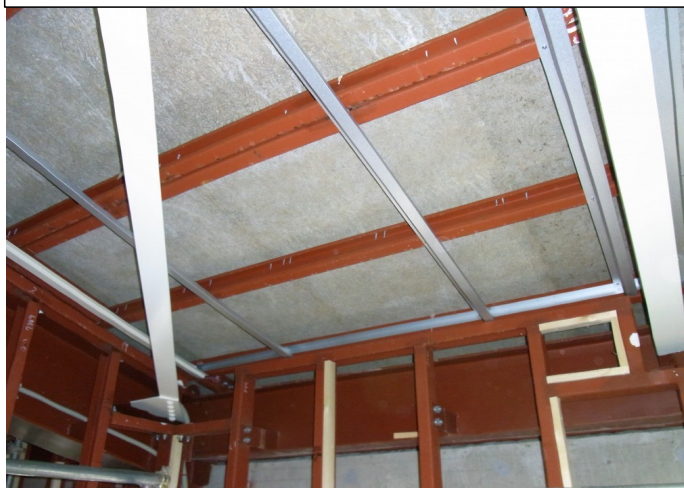
オープンスペース取付け
