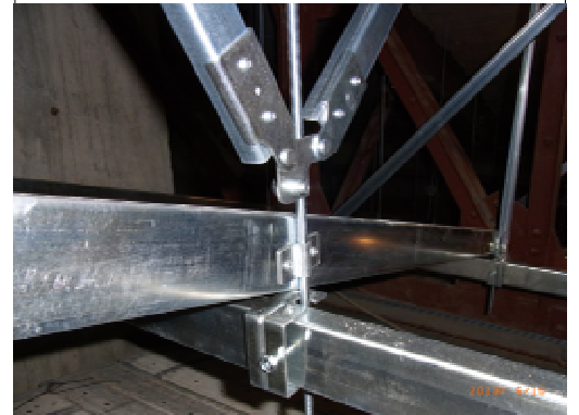
【上段部下地】下部取付状況
