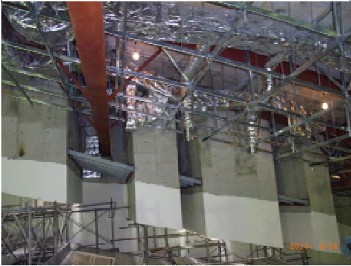
下段部下地(中間部水平・プレス補強)
