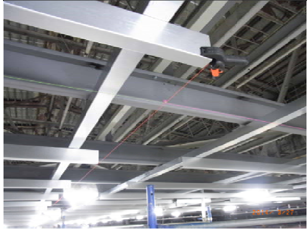
吊り天井下地補強状況 (勾配部)
