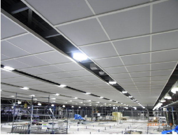
吊り天井下地補強状況 (勾配部)
