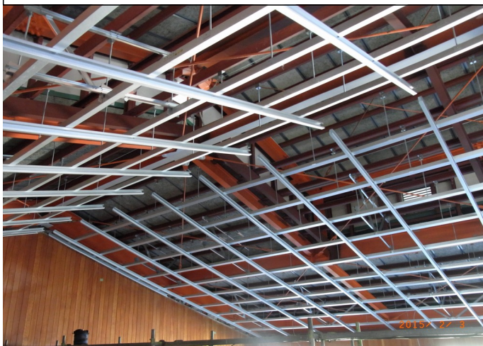
天井下地軸組み①
