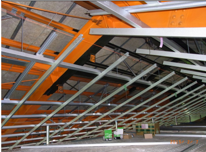
天井下地軸組み①
