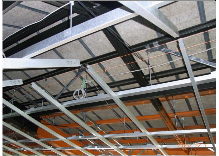
天井下地軸組み②
