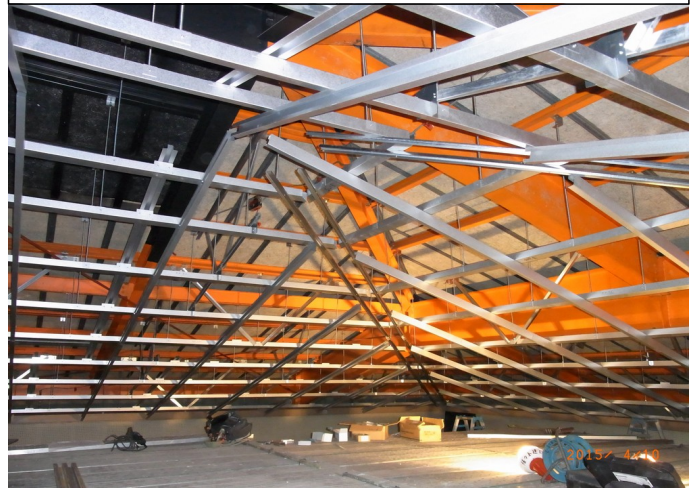
吊り下地組み
