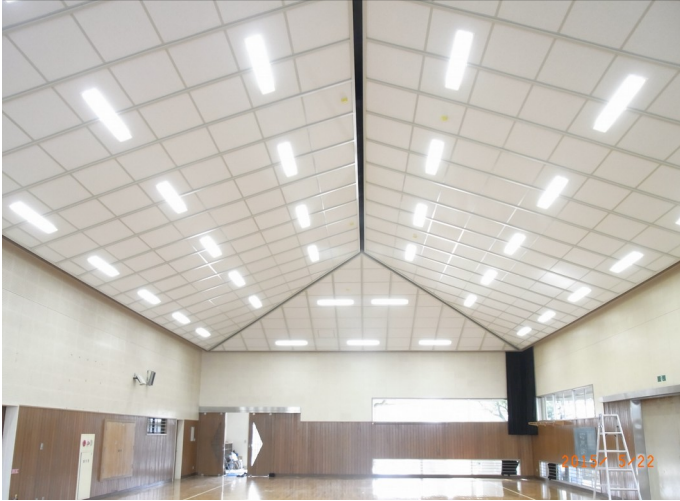
全景(施工後)①
