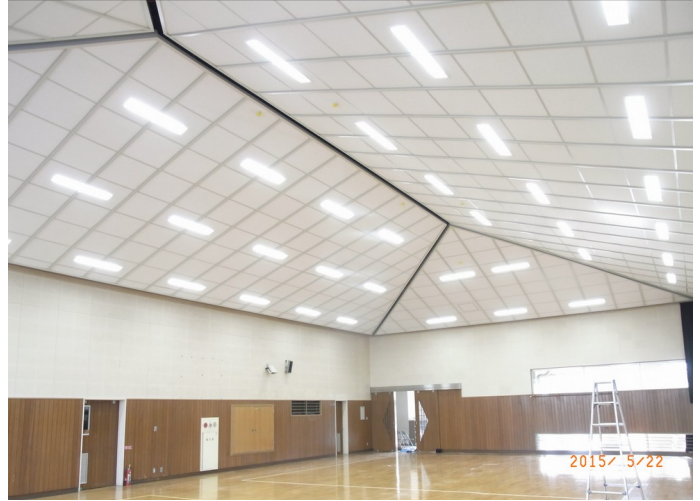
全景(施工後)②
