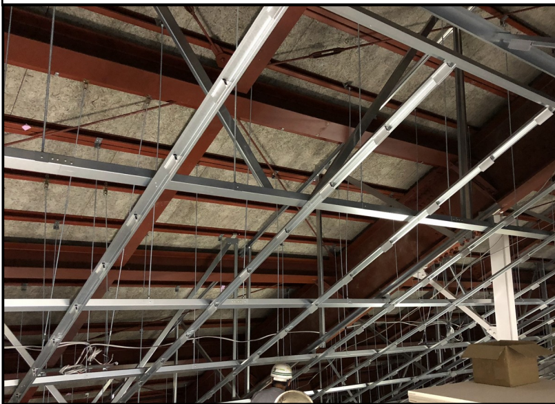
CPS耐震システム下地組状況①
