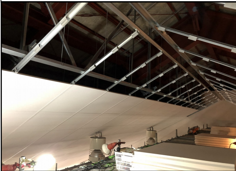
天井複合板挿入状況
