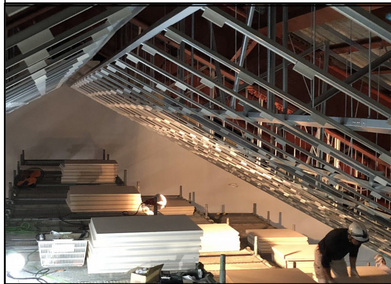
CPS耐震システム下地組状況②
