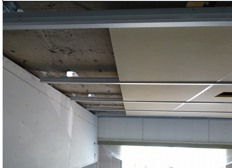
天井取り付け
