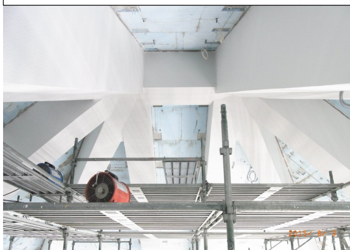
既存天井撤去後
