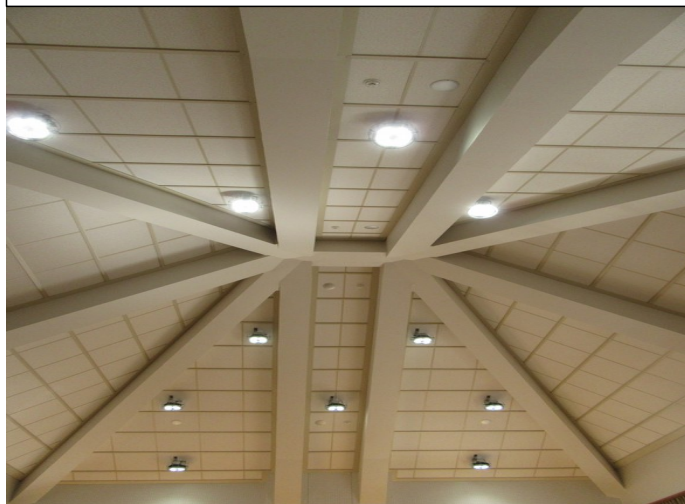
内観(施工後全景)
