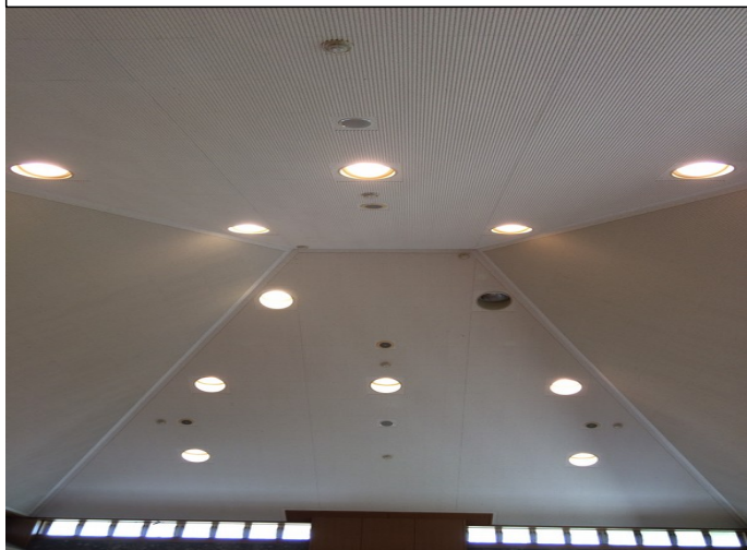
内観(施工前全景)
