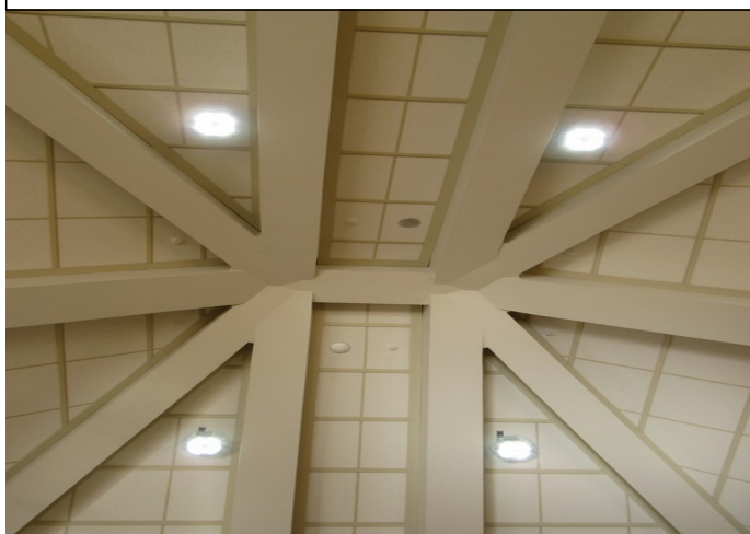
内観(施工後全景)
