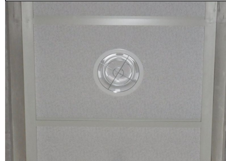
照明器具周辺部
