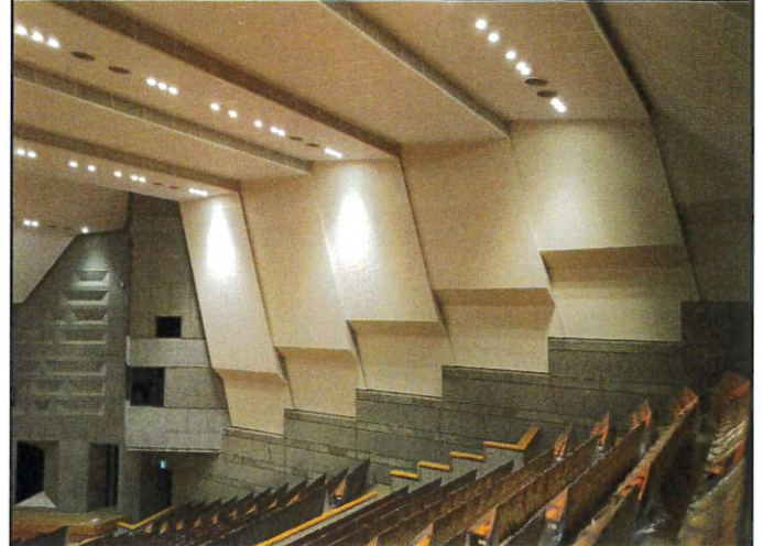
天井耐震改修後全景
