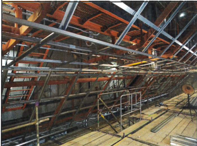
システム下地取付(途中)
