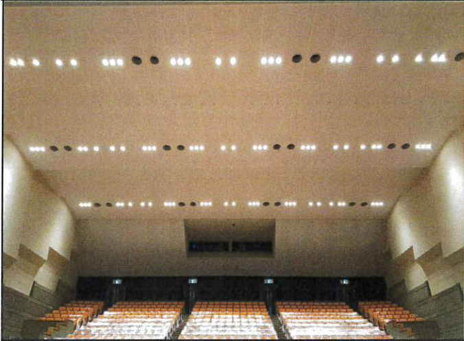
天井耐震改修後全景
