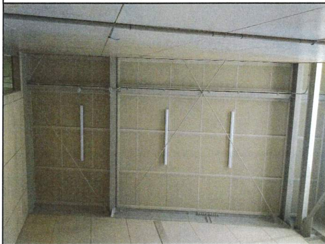
改修後ステージ上部
