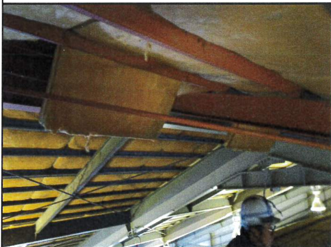
改修前断熱下地
