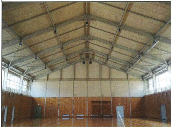
改修後天井全景
